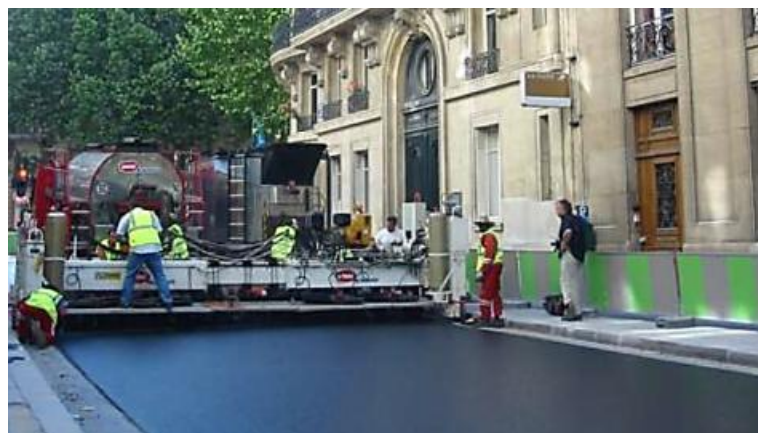
Figure I.36.Chausser avec l'asphalte coulé[70]
