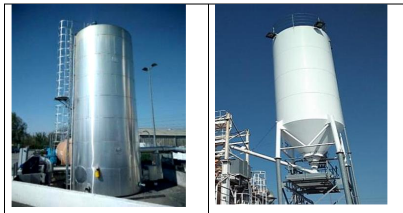
Figure I.51 (à droite) Silo filler de calcaire (à gauche) citerne de bitume chauffée (Nord Asphalte)
