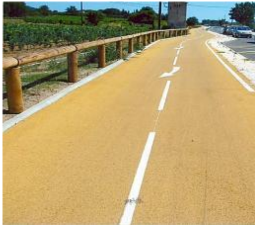
Figure I.40. pistes cyclables à l'asphalte coulé [74]
