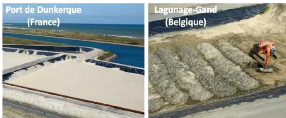
Figure I.20.exemple des bassins de séchage[93]
