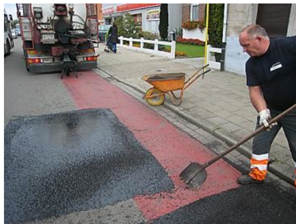
Figure I.39. Réparations à l'asphalte coulé [73]
