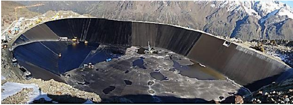
Figure I.38. Asphalte coulé pour Bassin
