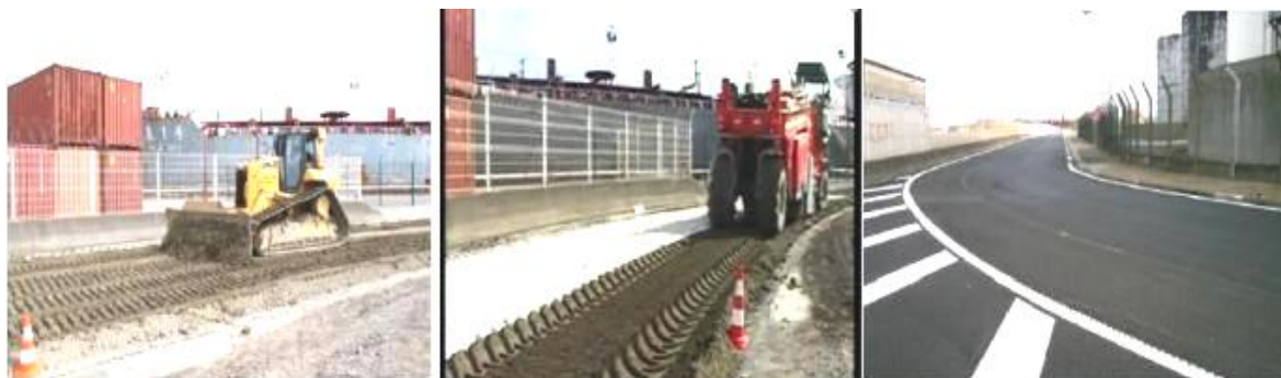
Figure I.28. Mise en œuvre de la route du Freycinet 12 à base de sédiments de dragage du GPMD[64]
