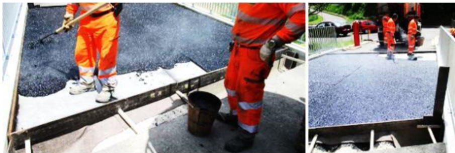
Figure IV.2 Application de l'asphalte coulé dans les ponts
