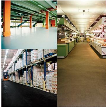
Figure I.35.revêtement sol industrielle
