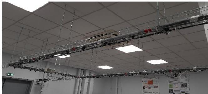
Figure 4 : Ligne de prélèvement
