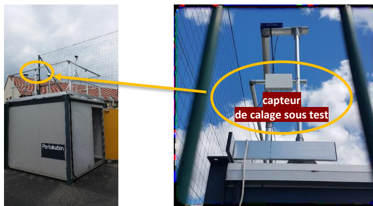
Figure 5 : exemples d'installation de capteurs de calage sur station péri-urbaine ATMO HdF
