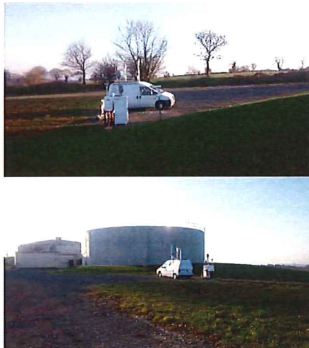
Figure 2: Photographies de l'implantation du camion laboratoire, des préleveurs extérieurs au regard de la distance les séparant du réservoir d'eau de la SDAEP
