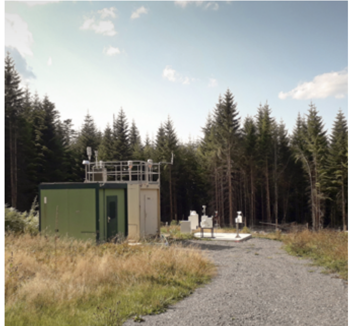
Site du Donon après finalisation des travaux et transfert du programme de mesure de Jonville. (Extrait du rapport d'activité MERA 2018)
